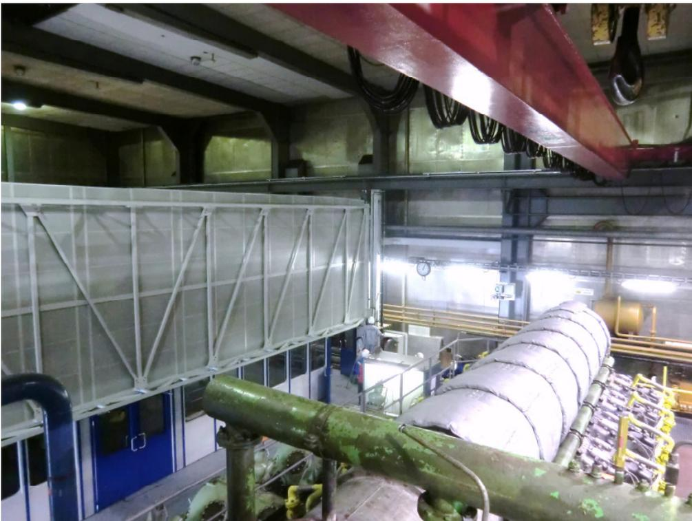
Trennwand in heruntergefahrenem Zustand. Rechts oben ist der Hallenkran zu erkennen.
